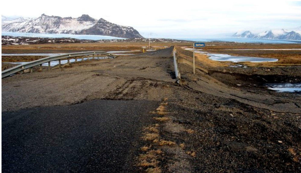
1. mynd: Hringvegurinn við Kvísker hefur ítrekað skemmst í ofsaveðrum þegar hluti slitlagsins flettist af veginum. Hér er horft til norðurs í átt að Fjalls- og Breiðamerkurjökli. Ljósmynd: Sigurður Gunnarsson, Hnappavöllum.
